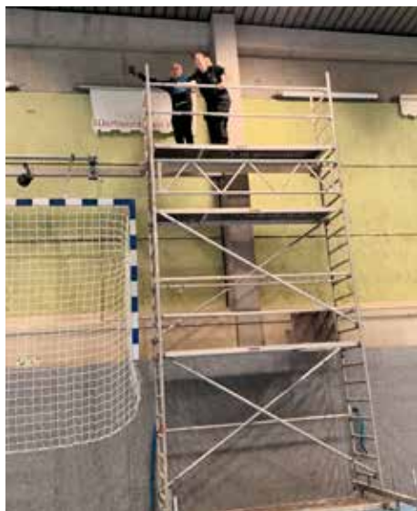
Aufbau des Rollgerüsts durch die Fa. Clermont, entfernen des alten Rollosystems, Anbringung des neuen sowie Bestückung mit den z.T. neuen Werbe rollos.
